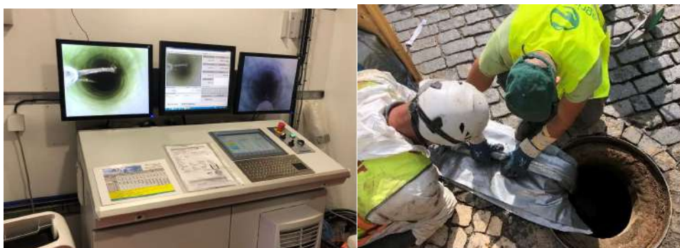
Figura 6 - Reabilitação de coletores sem abertura de vala, com recurso ao método Cured in Place Pipe (CIPP) com cura UV
