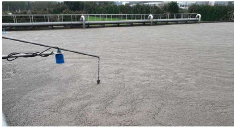
Figura 31 – Tanques de arejamento da ETAR de Frossos
