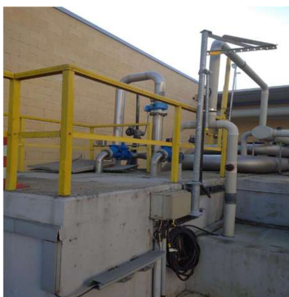
Figura 29 - Substituição de Grupos Eletrobomba na ETAR de Frossos
