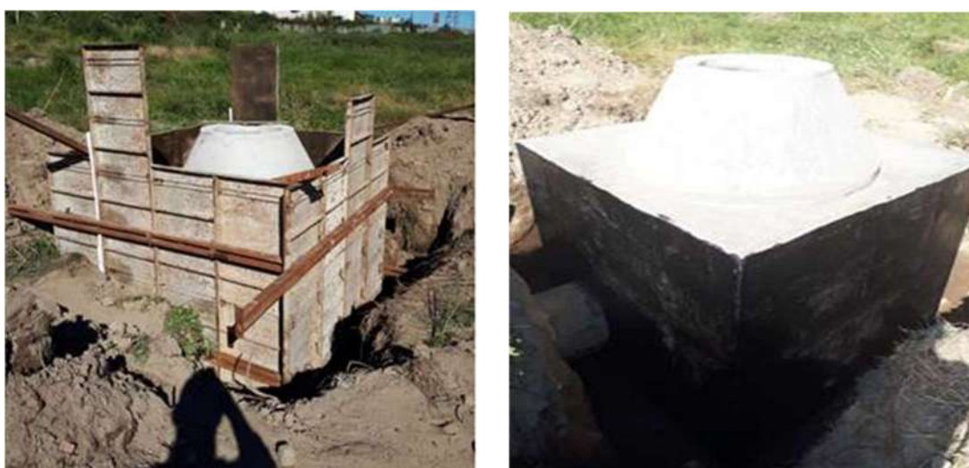
Figura 25 - Reparação e execução da nova caixa de visita
