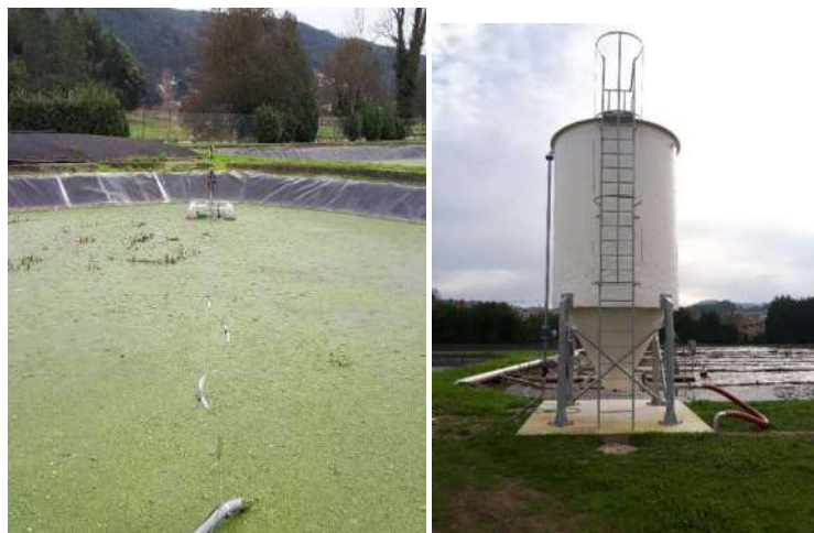
Figura 32 - Instalação de sistemas de extração de lamas e de Espessadores de lamas
