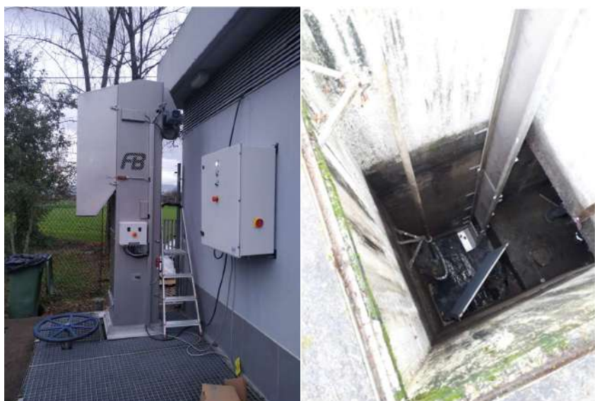
Figura 34 - Instalação de grelha vertical na câmara de chegada
