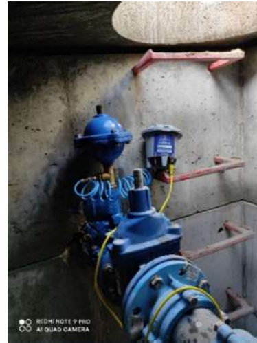
Figura 14 - Válvula redutora de pressão
