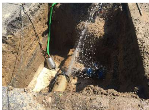
Figura 4 - Reparação de avarias em condutas e ramais
