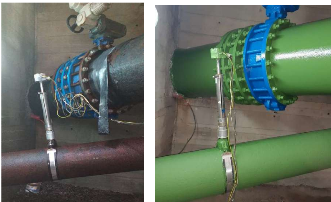
Figura 26 - Beneficiação de equipamentos e tubagem da conduta DN1200
