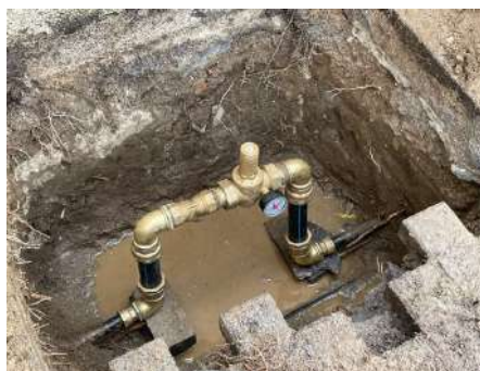
Figura 19 - Instalação de VRP
